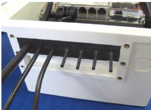
ゴムパッキンをスロットに押し込む
